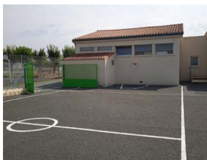
Aménagement d'un terrain de basket
